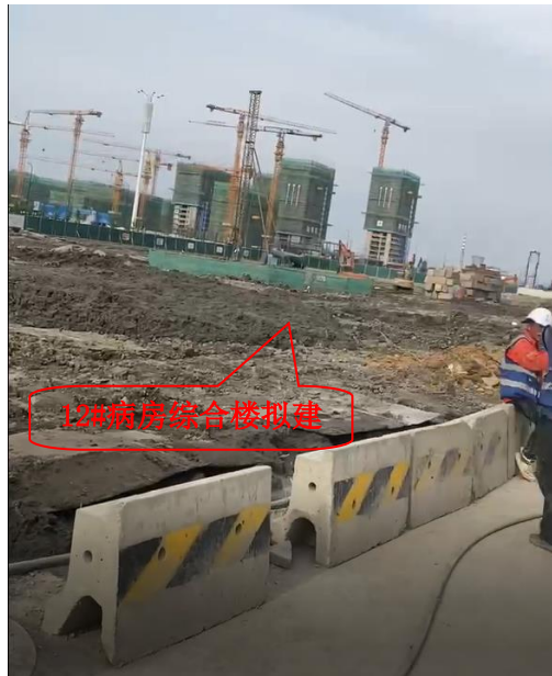
图 8-1 12#病房综合楼拟建场址
