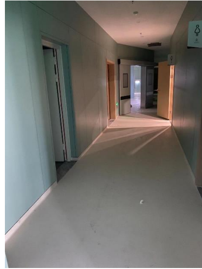
图 8-5 DSA 杂交手术室拟建址北侧
